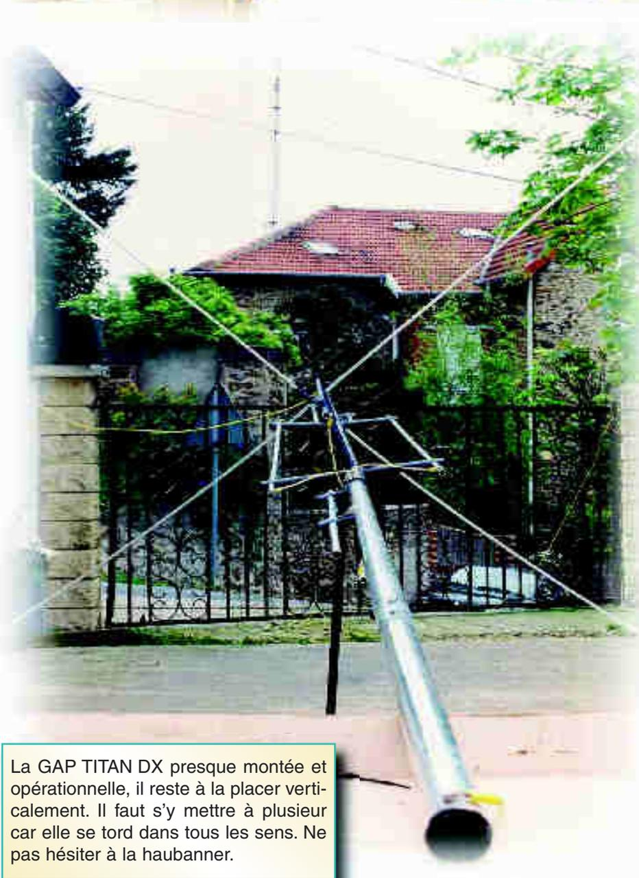
La GAP TITAN DX presque montée et opérationnelle, il reste à la placer verticalement. Il faut s'y mettre à plusieurs car elle se tord dans tous les sens. Ne pas hésiter à la haubanner.
